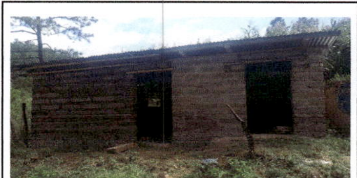
Foto 10: Repello en muro.
