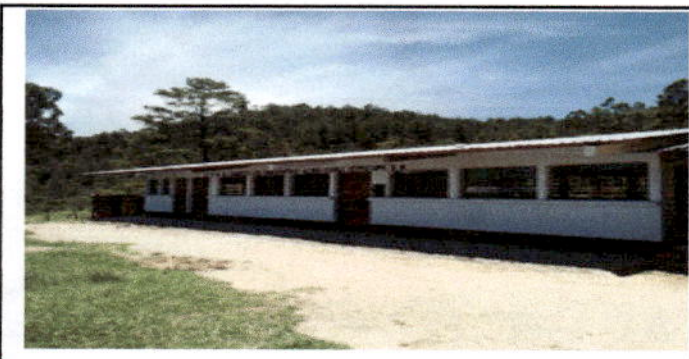
Foto 5: Fabricación e instalación de balcones de hierro en ventana.
