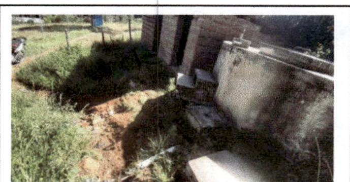
Foto 4: Sustitución de piso de torta de concreto 10cm de grosor.
