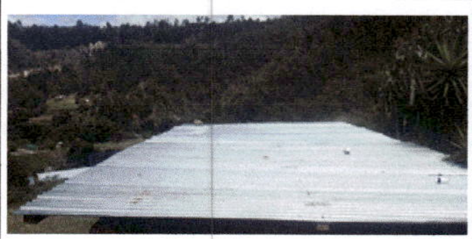
Foto 2: Sustitución de elementos de fijación.
